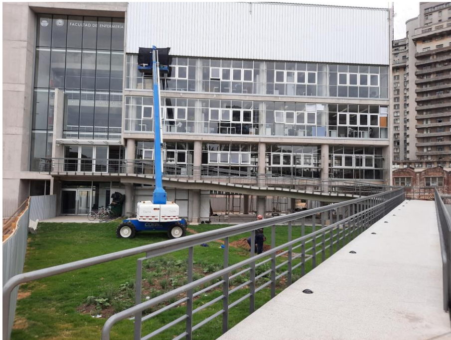
Imagen Nº 03 – Acceso a la edificación
