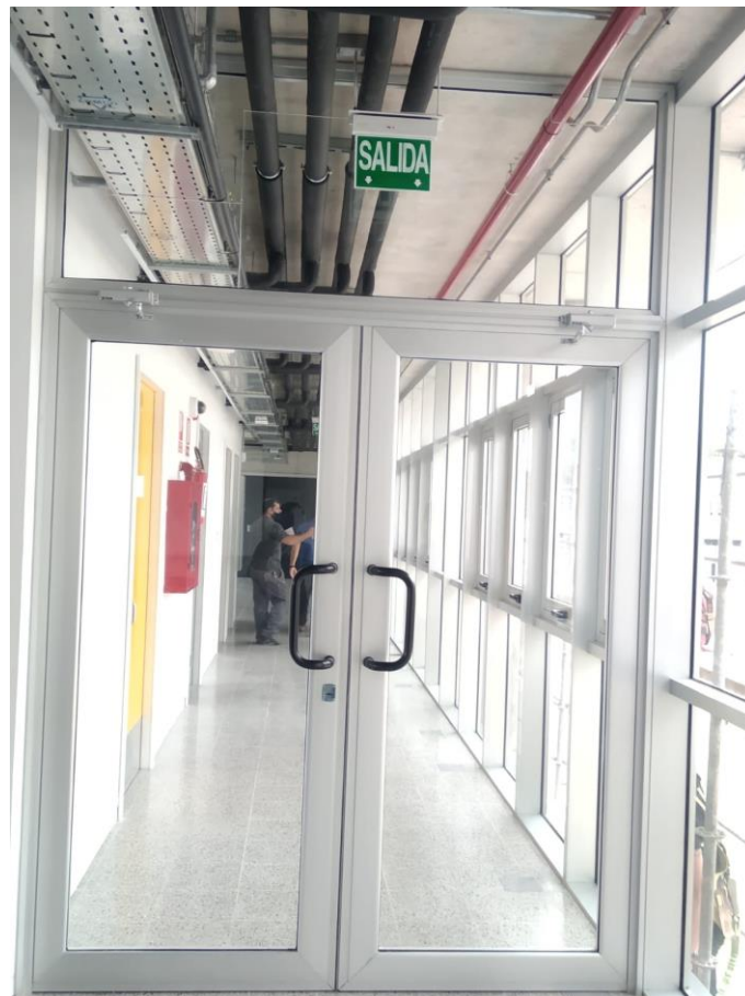
Imagen N°06 – Circulación y señalización de salida
